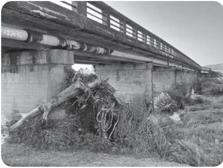
爪痕が残る、旧朝日橋の橋脚
